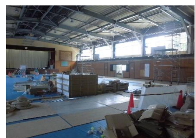
体育館照明・空調工事
