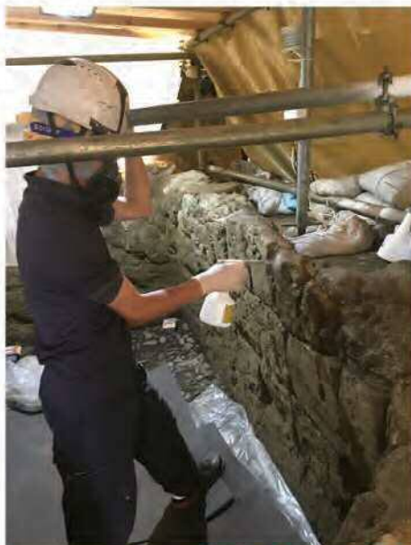
石材に薬剤を噴射しています
