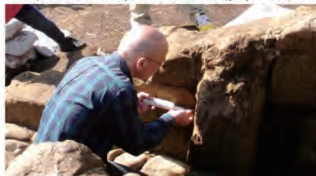
針を石にさして強度を確認しています
