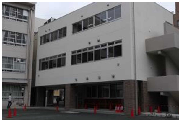
屋外運動場から見た増築棟
