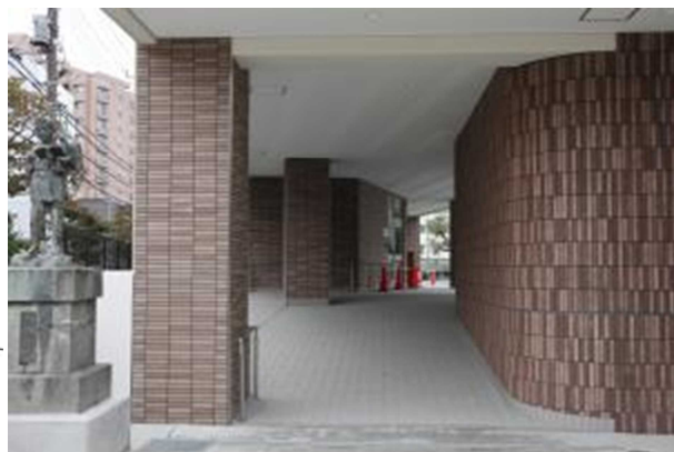
増築棟ピロティ部分(東門側)
