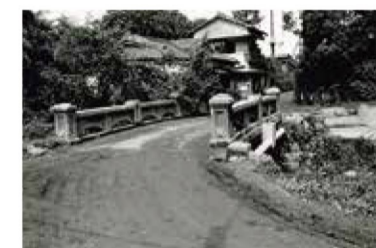
田中橋 (昭和39年) B-3 橋の欄干の一部が近くの稲荷の脇に残っています。また、地点標識に田中橋の名が残っています。
