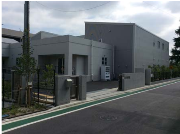
給食センター外観
