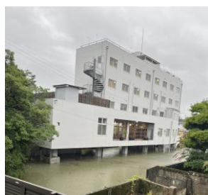
【昨年度川が氾濫し、水没した施設】
