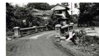
田中橋 (昭和39年) B-3 橋の欄干の一部が近くの稲荷の脇に残っています。また、地点標識に田中橋の名が残っています。
